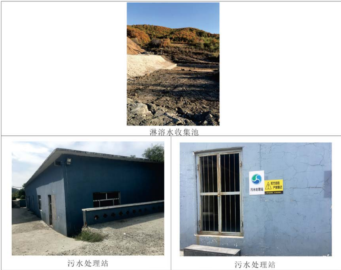
图 4.2-1 技改工程部分水环境保护措施落实现场图
