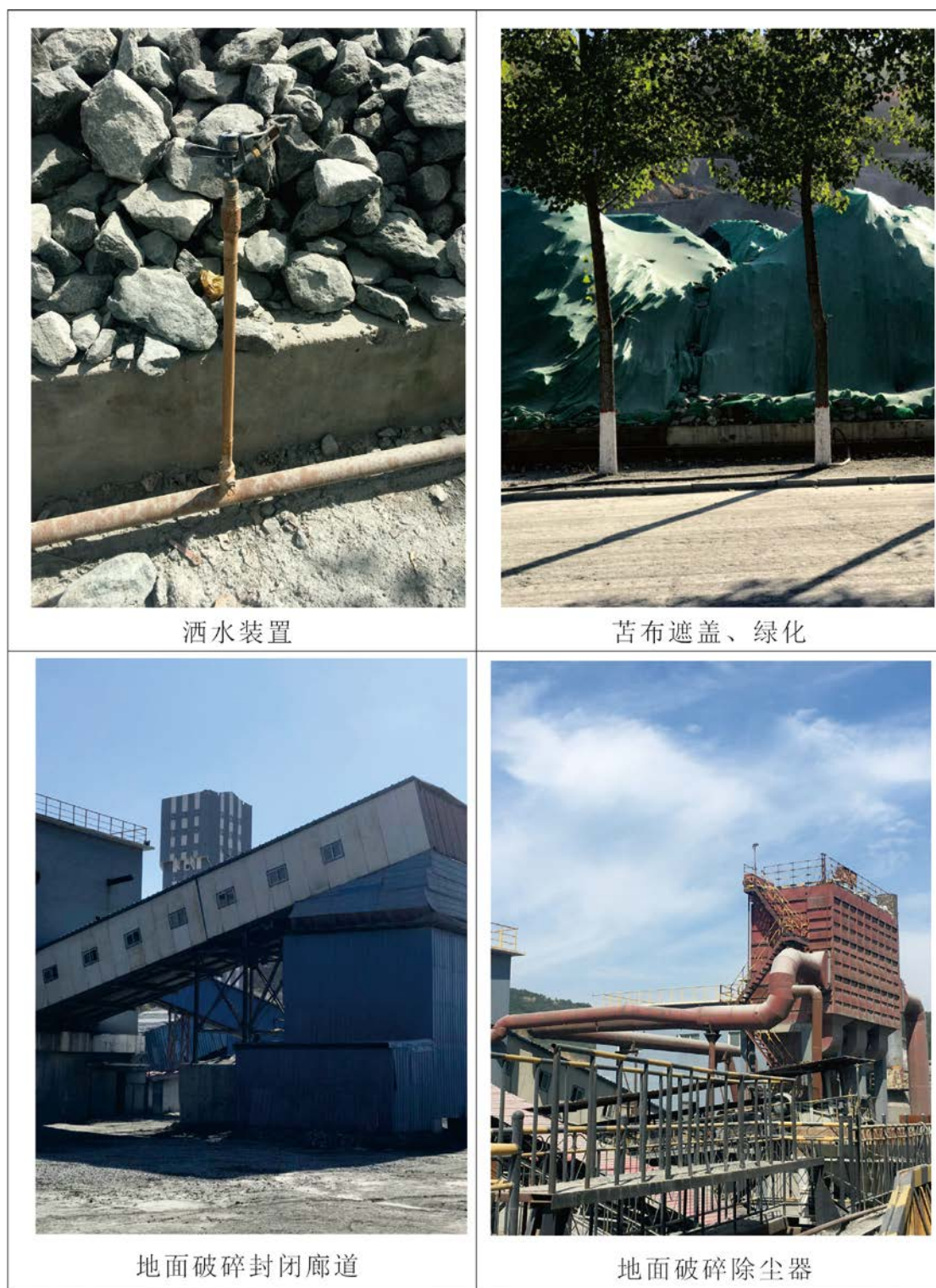
图 4.1-1 技改工程部分环境空气保护措施落实现场图
