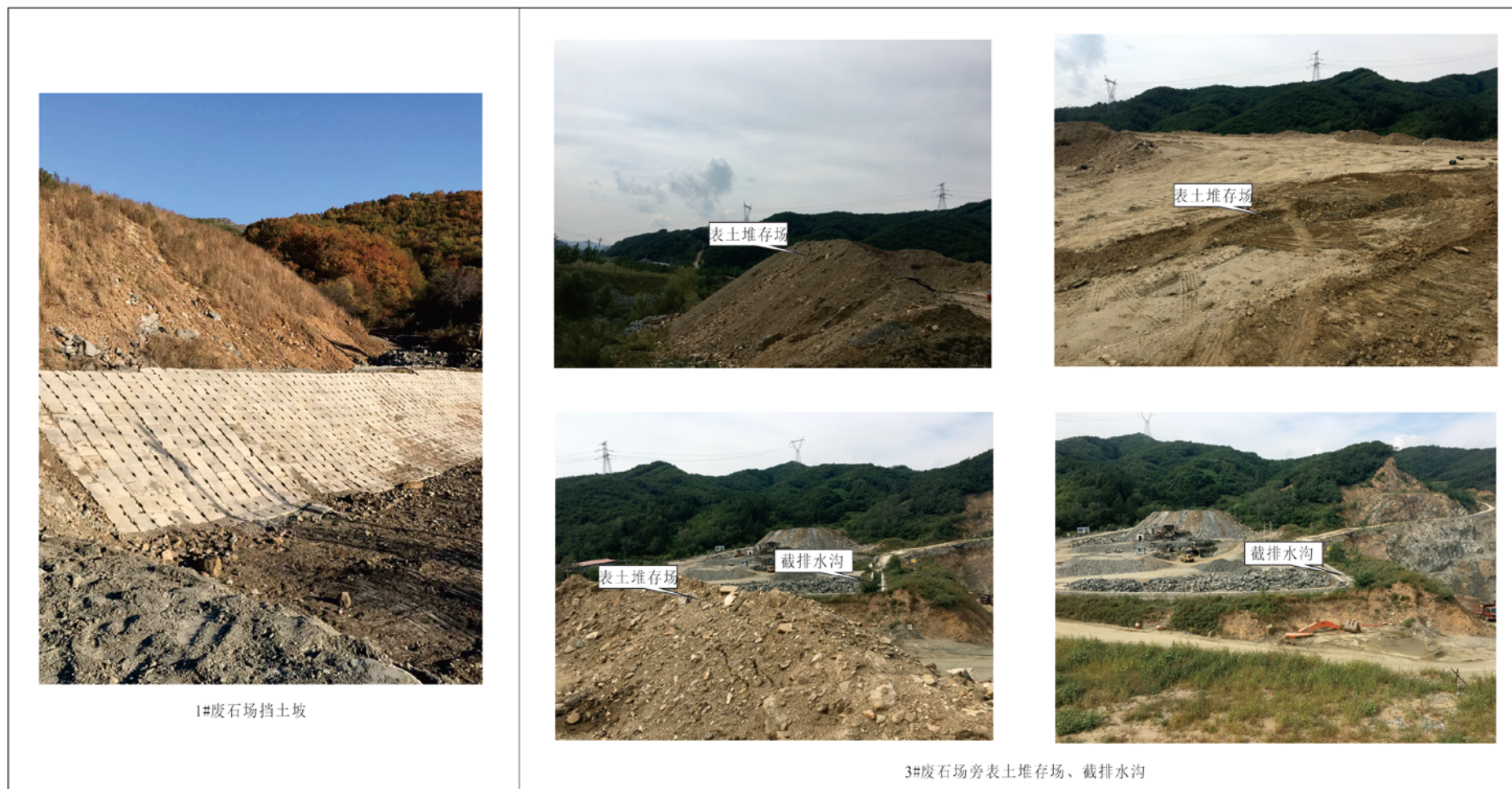
图 4.5-1 技改工程部分生态环境保护措施落实情况现场图
